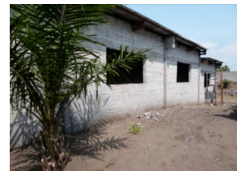
Het nieuwe schoolgebouw heeft nog geen deuren en ramen met tralies.
